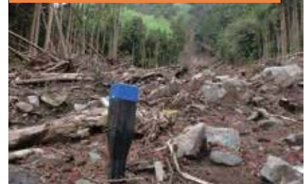
使用事例：災害後の工事安全管理対策
